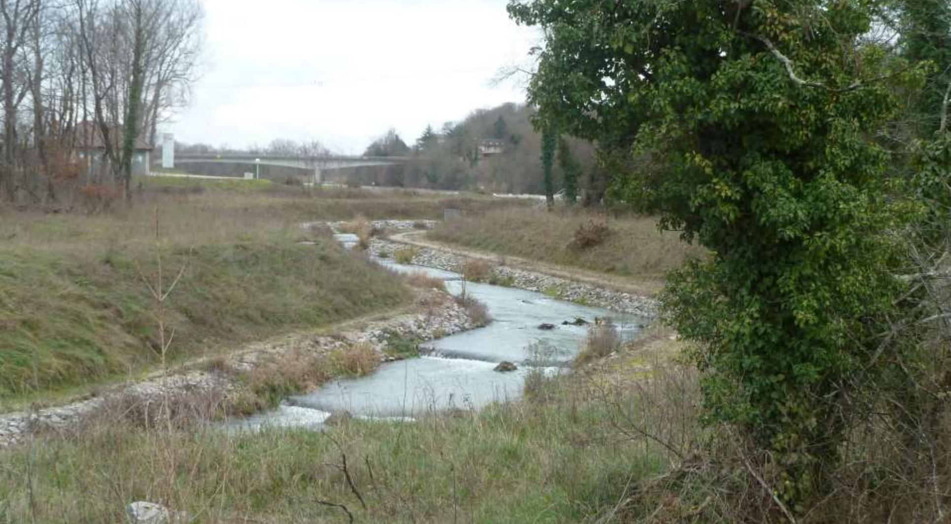
Vue de la passe à poissons : un aménagement unique sur le Rhône, composée de 32 bassins successifs qui constituent une véritable rivière artificielle de 300 mètres de long, la passe permet aux poissons de contourner le barrage et de transiter entre les canaux de Jonage et de Miribel. (dénivellée : 6 mètres) En 2014, ce sont plus de 82 000 poissons qui ont emprunté la passe !
