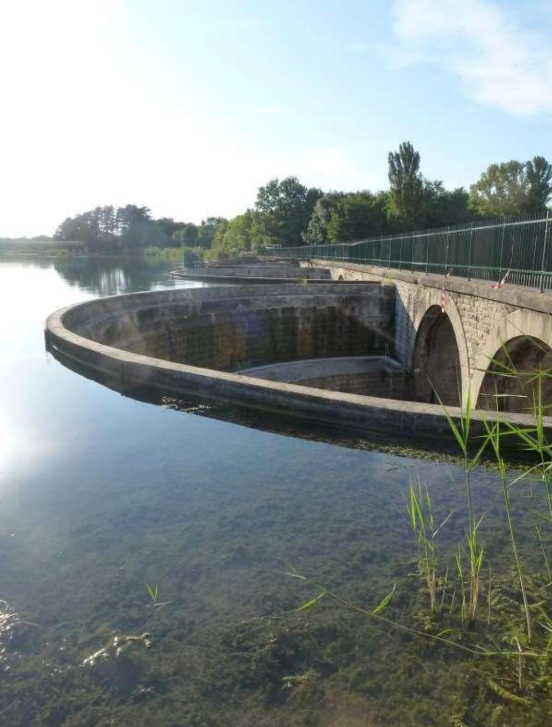
**Le déversoir en amont du Pont d'Herbens non prévu à l'origine, sa fonction consiste à écouler un trop plein accidentel en cas d'incident au mur de garde (barrage de Jonage)**
